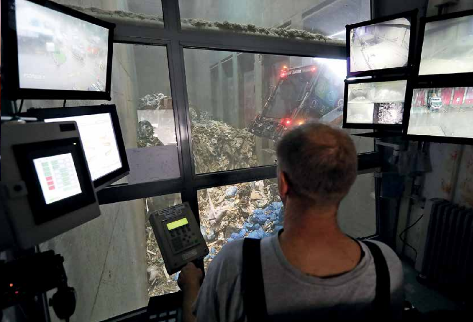
Im Abfallbunker sorgt der Kranführer hinter bruchfesten Glasscheiben dafür, dass die Verbrennungsöfen optimal befüllt werden.
