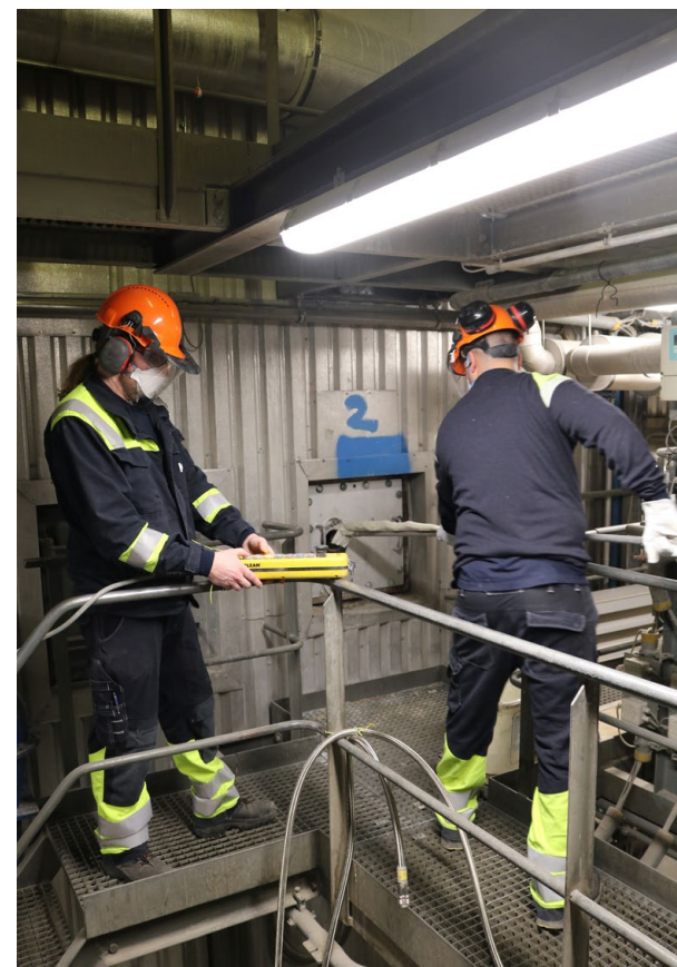
Die KEZO-Mitarbeitenden sind optimal für die Druckwellenreinigung ausgebildet.
