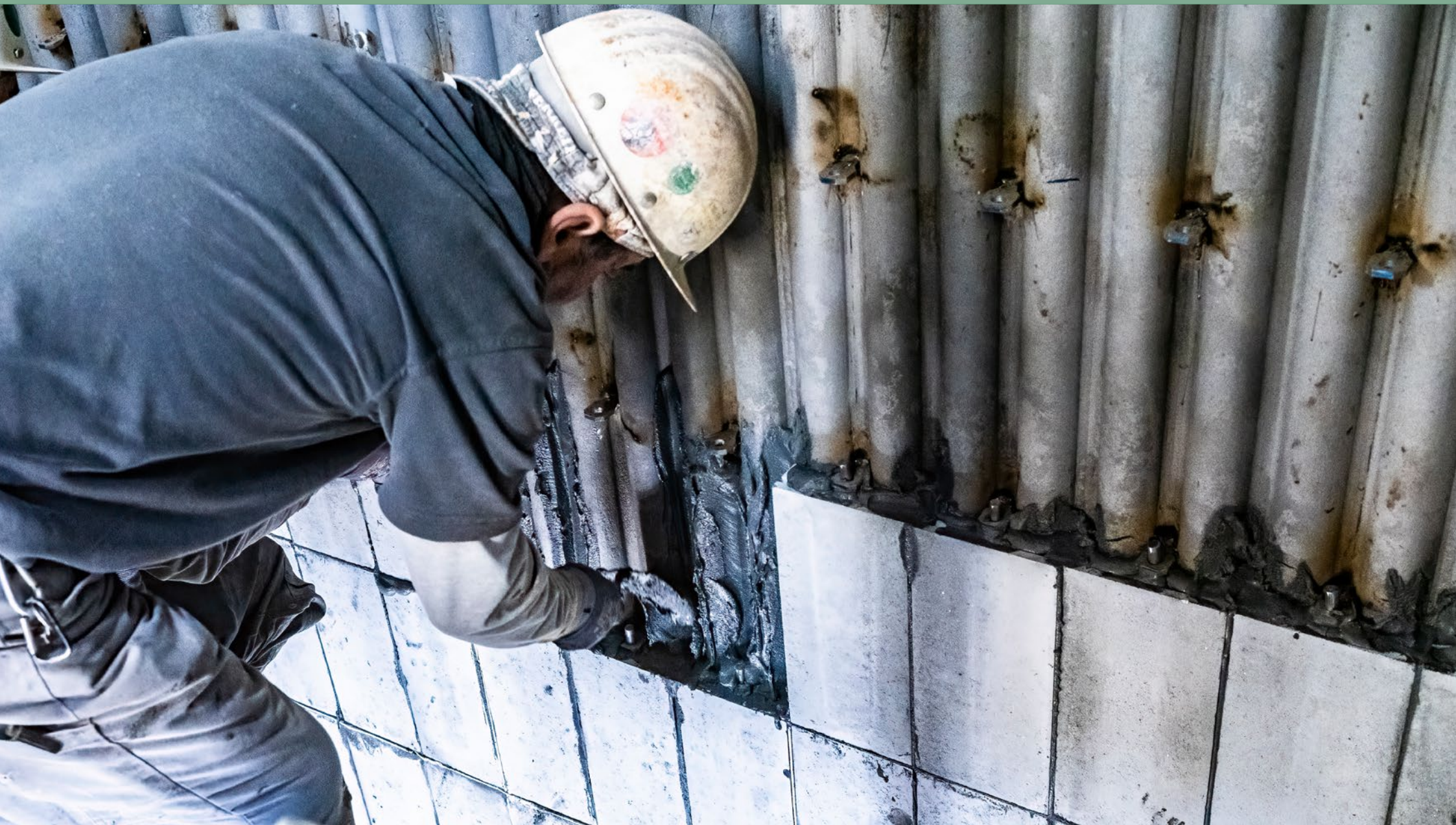
Feuerfest-Material an der Ofenwand wird ersetzt.
